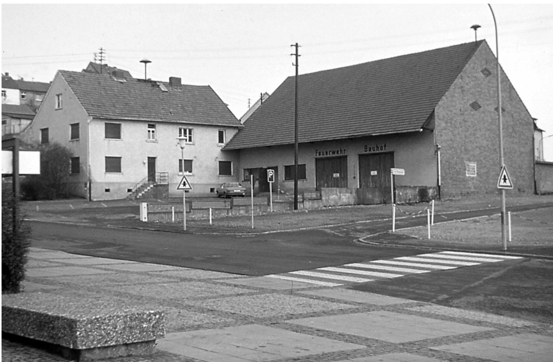
Aufnahme um 1975 Nutzung als Bauhof u. Feuerwache (Hs.-Nr. 2 ½ bereits abgerissen)
