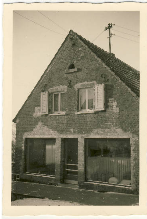
obere Giebelseite mit ehemaligen Schaufenstern der Polsterei
